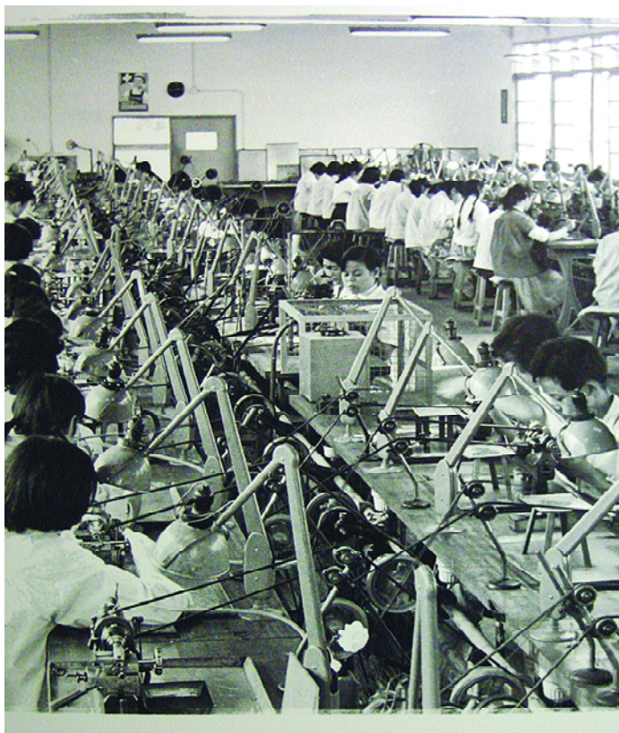
Assemblage de pièces pour montres-bracelets sur ces chaînes de montage ; vers 1950.
